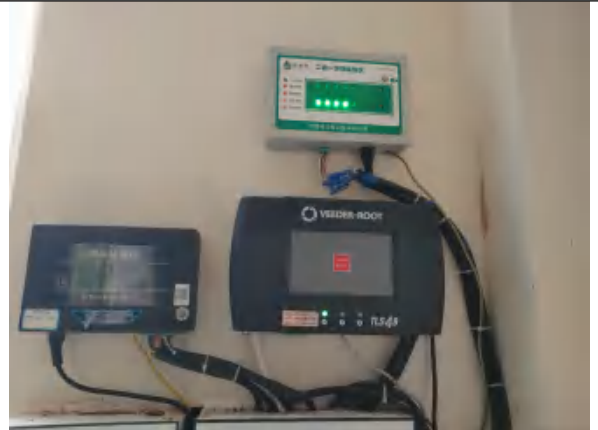
图 16 (油罐、管道) 泄漏检测仪和液位仪
