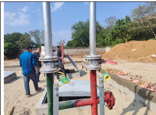
图 10 汽油通气管闸阀
