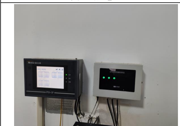
图 14 液位仪和测漏仪
