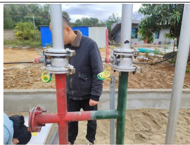
图 19 通气管阀门
